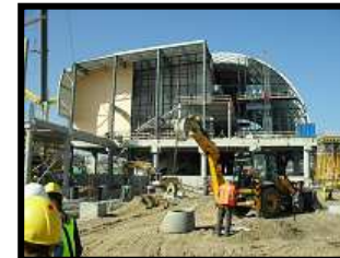
Budowa dworca PKP Poznań
