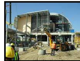
Budowa dworca PKP Poznań
